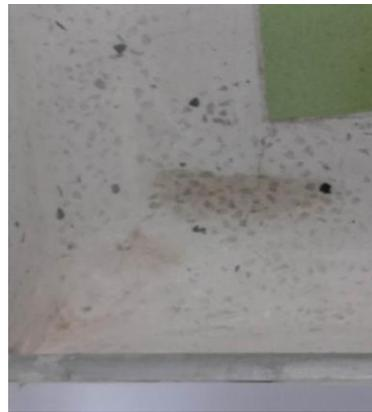
Foto 6-7: Deficientes remates ítem 7.3 “Suministro e instalación de media caña en granito pulido”.
