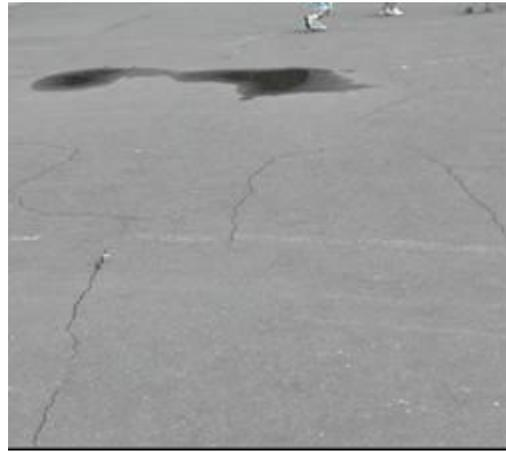
Foto 13: Fisuras longitudinales.
