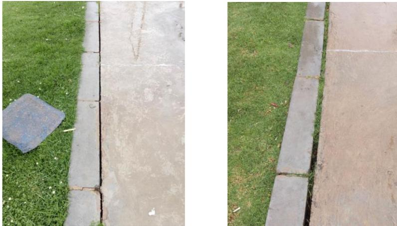
Foto 20-21: Separación de la placa con el bordillo.
