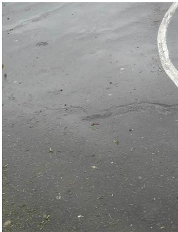
Foto18: Fisuras longitudinales.
