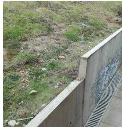
Foto N° 1 - 2. Se observa que el muro ubicado en la parte posterior de la calle 22 sur con carrera 1A presenta una leve inclinación en su corona.
