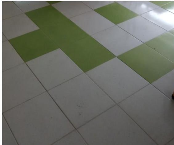
Foto 10. La dilatación del enchape de piso no es continuo debido a que la pieza verde presenta diferencia de 3 mm con la pieza blanca.
