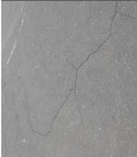
Foto14: Fisuras longitudinales.
