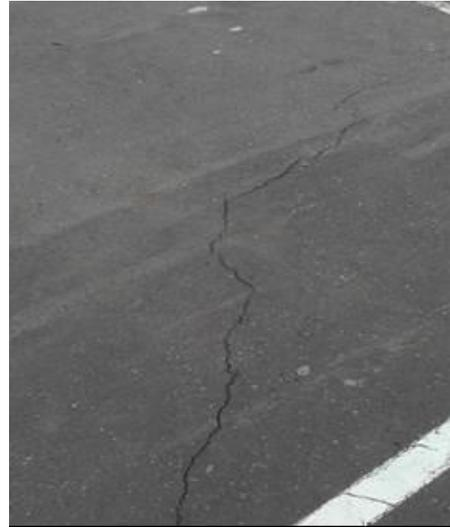
Foto 15: Fisuras longitudinales.
