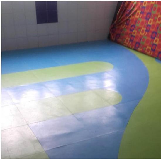
Foto 11. Desprendimiento y desnivel del piso ítem 7,1 “Suministro e instalación de piso en caucho 6 mm (incluye pirlanes y remates)”.
