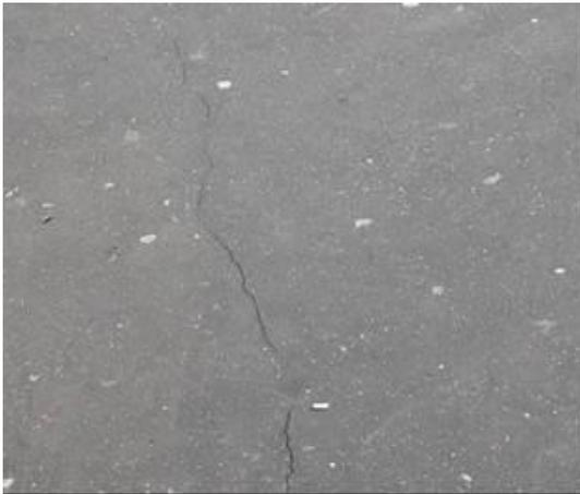
Foto 16-17: Fisuras longitudinales.
